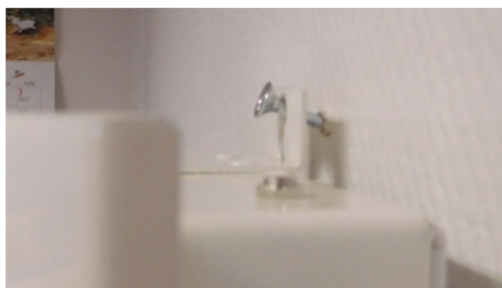
Fästs-kruven installeras lite snett uppåt, skruvhuvudet ca. 20 mm från väggen
