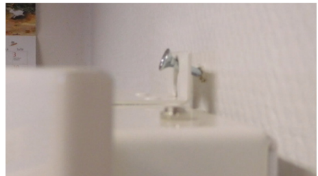
Kiinnitysruuvi asennetaan hiukan vinosti ylöspäin, kanta n. 20 mm irti seinästä
